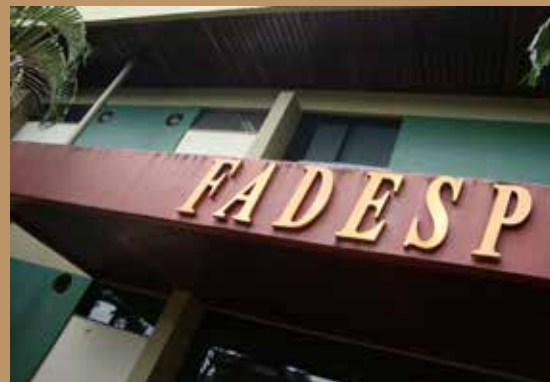
Prédio da Fadesp na UFPA (fotos 1,2 e 3)
