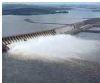
II. Usina Hidrelétrica de Tucuruí – 350Km de Belém/PA – WebCollection
