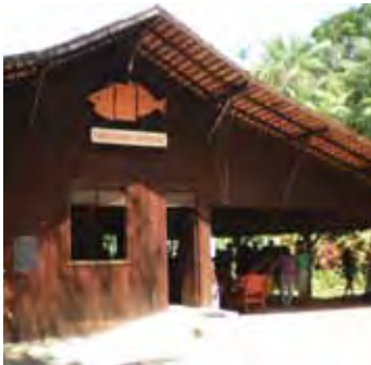
Fachada da Escola de Pesca — José Bittencourt
