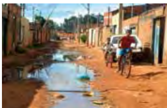
Esgoto a céu aberto no interior do Estado do Pará – WebCollection
