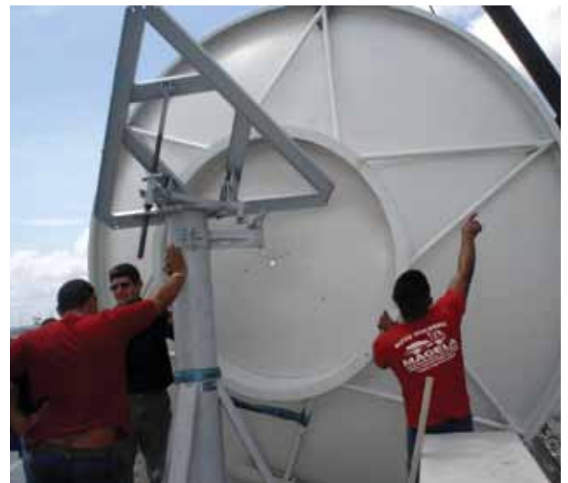
Instalação de nova antena: o projeto Up Link sendo executado
