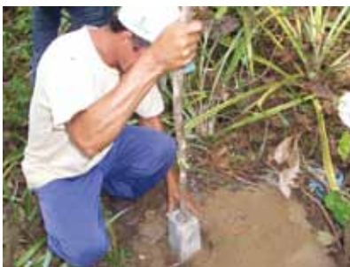
Marcos Territoriais - construção, transporte, colocação
