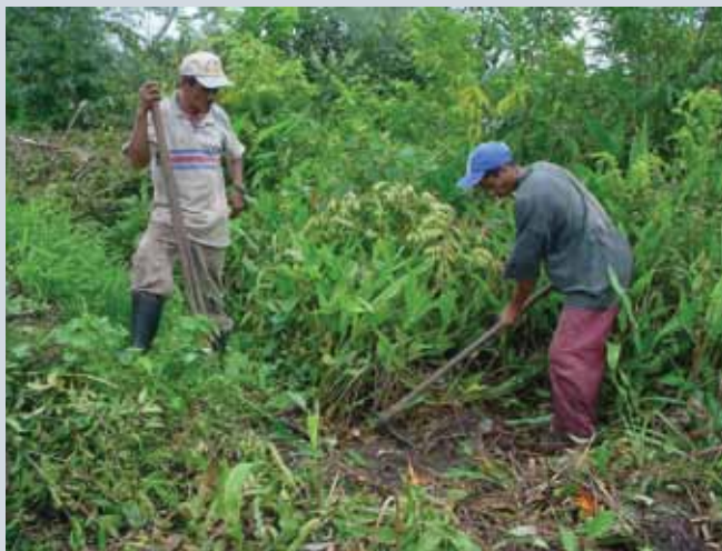
Limpeza no entorno do lote onde será implantado o Marco de concreto
