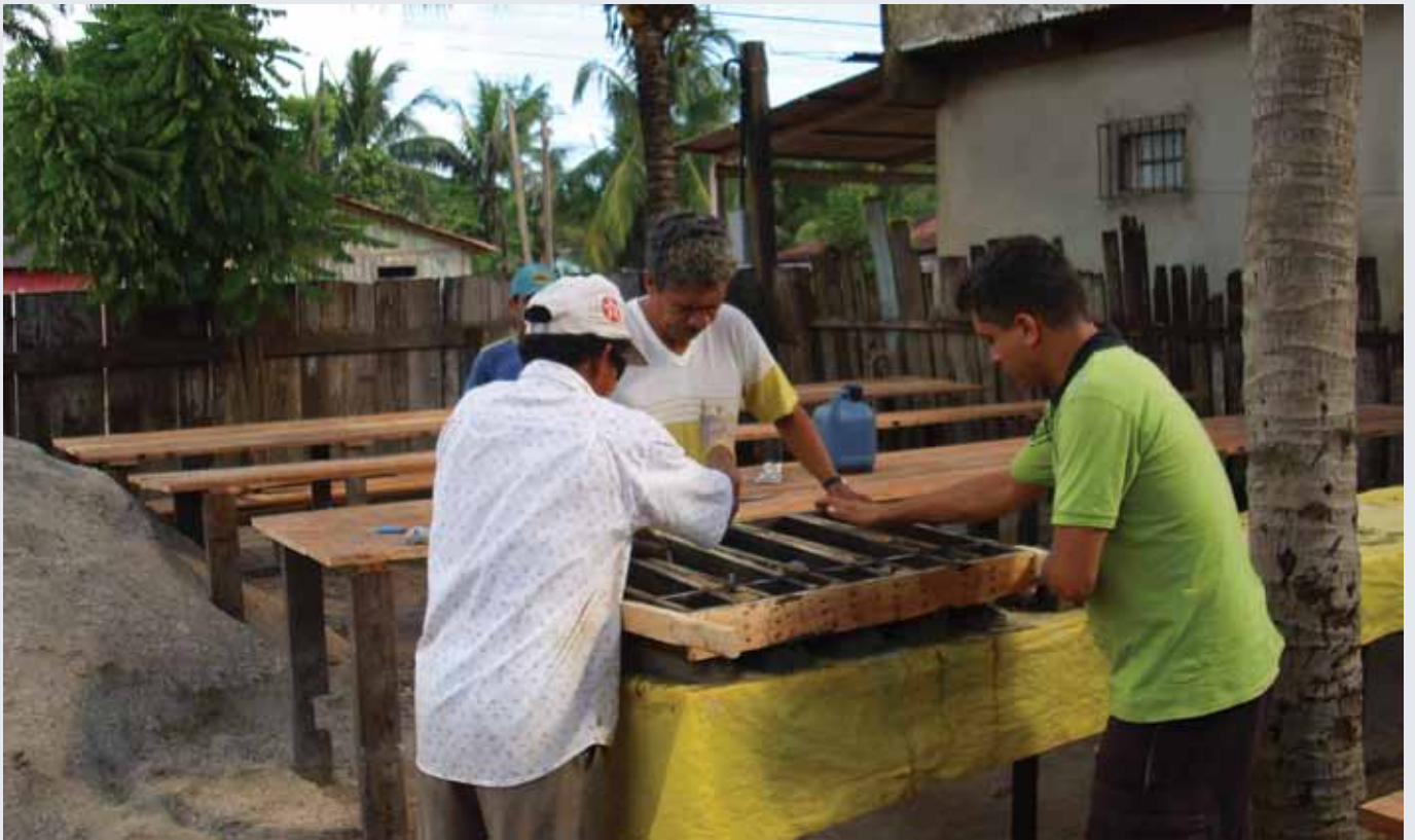
Confecção dos Marcos de concreto
