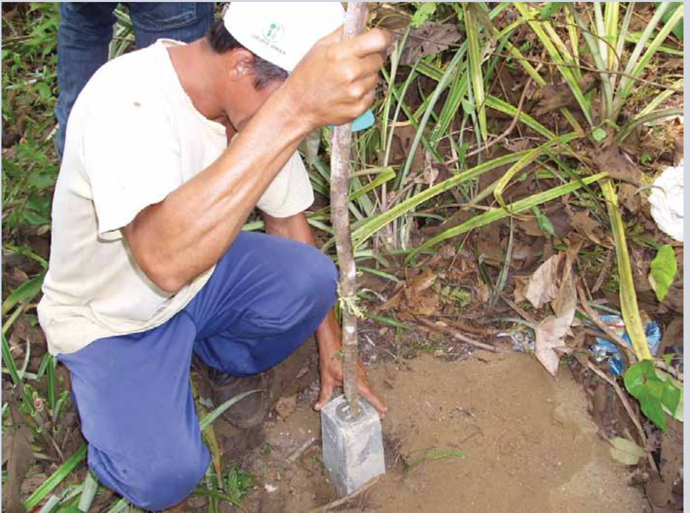
Assentamento do Marco de concreto
