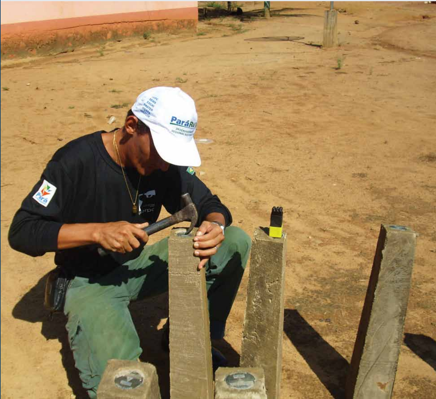
Produção dos Marcos de concreto
