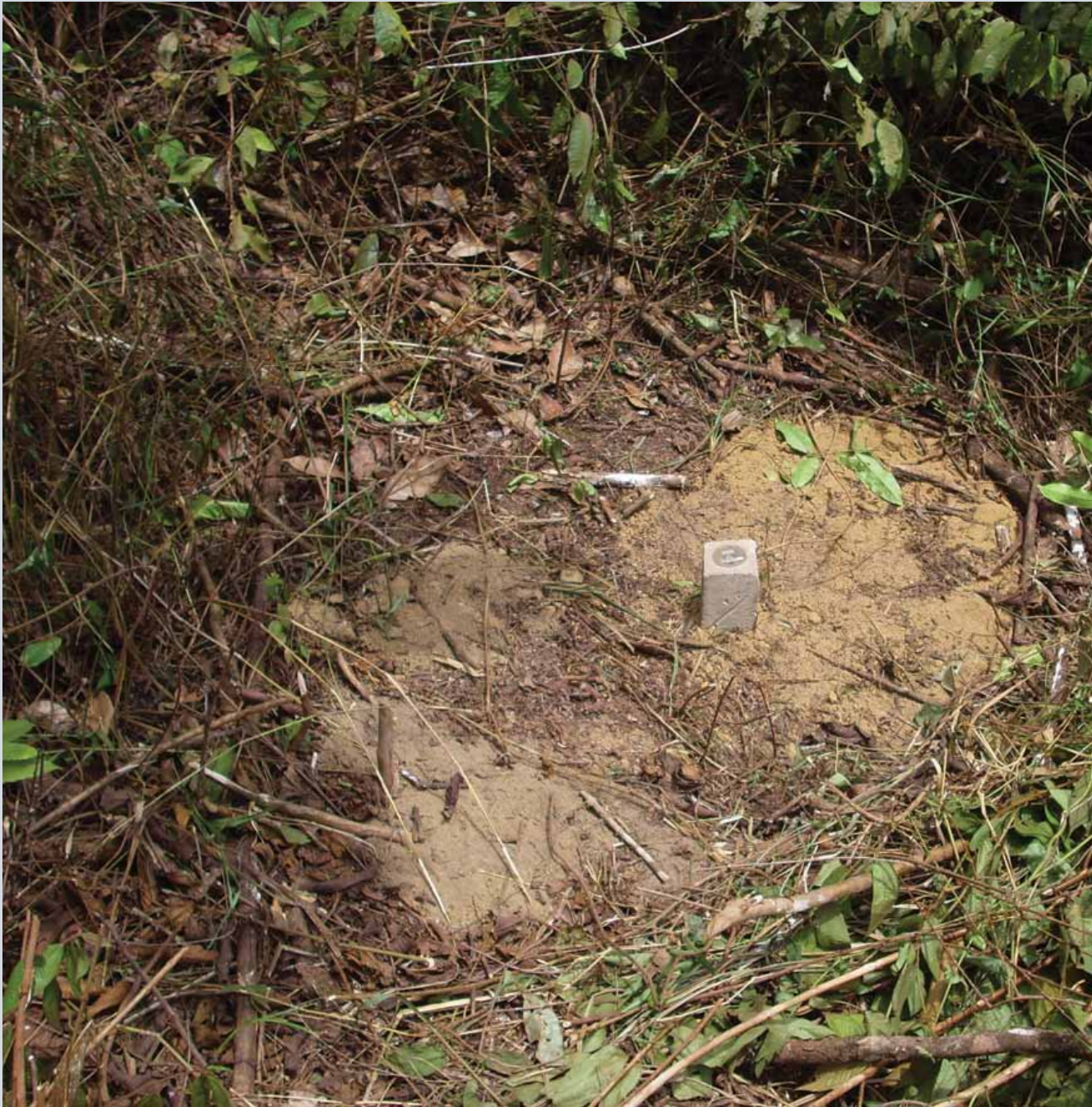
Marco de concreto depois de assentado
