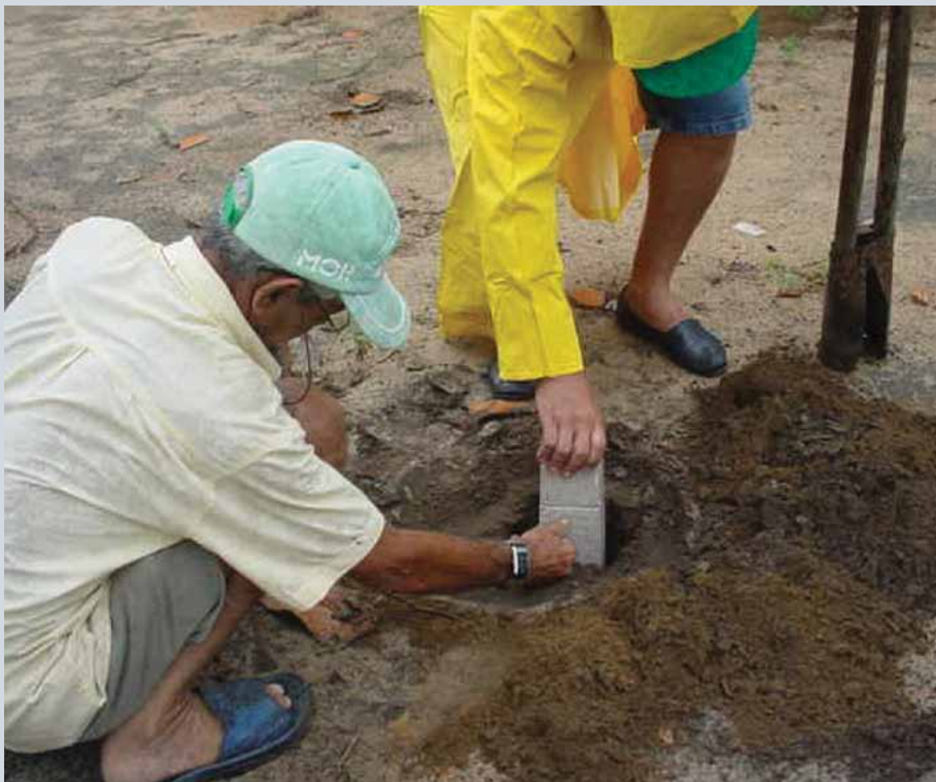
Assentamento do Marco de concreto
