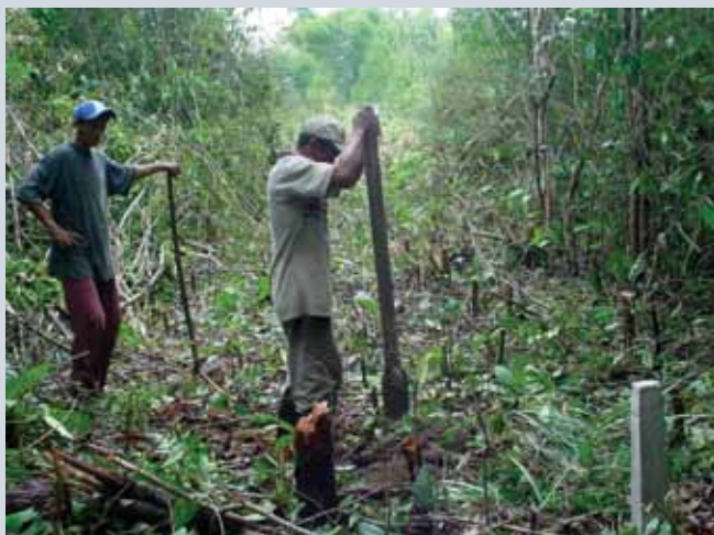
Preparação do terreno (buraco) para implantação do Marco
