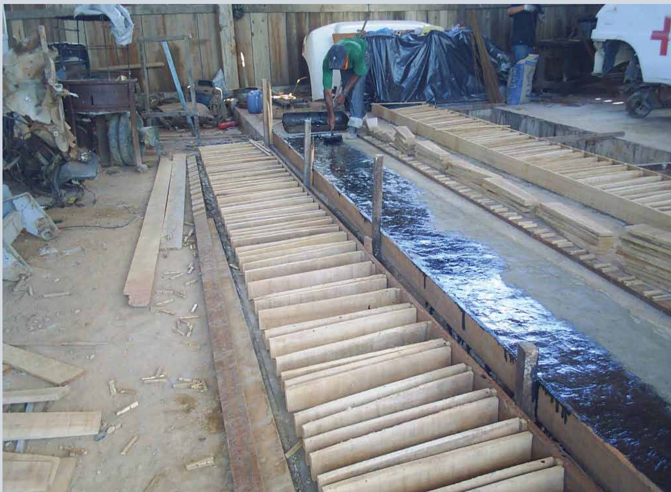
Confeção dos Marcos de concreto
