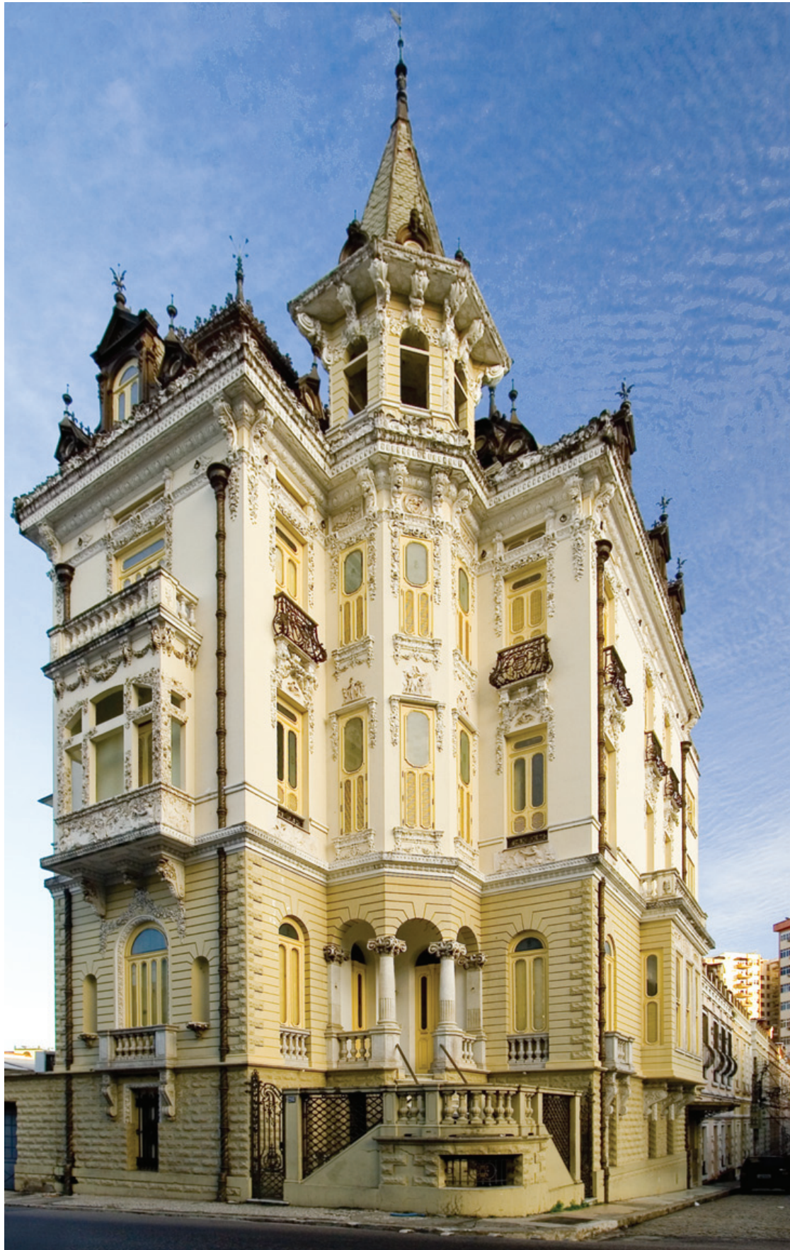
PALACETE BOLONHA, construído no período da Belle Époque – DETALHES art nouveau – Avenida Governador José Malcher esquina com Doutor Moraes - Belém - Pará - Brasil
