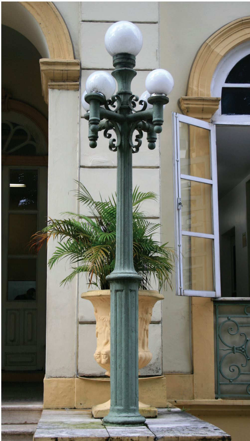
DETALHE da fachada do CODEM, construído no período da Belle Époque – luminária art nouveau – Avenida Nazaré, esquina com Quintino Bocaiúva - Belém - Pará - Brasil
