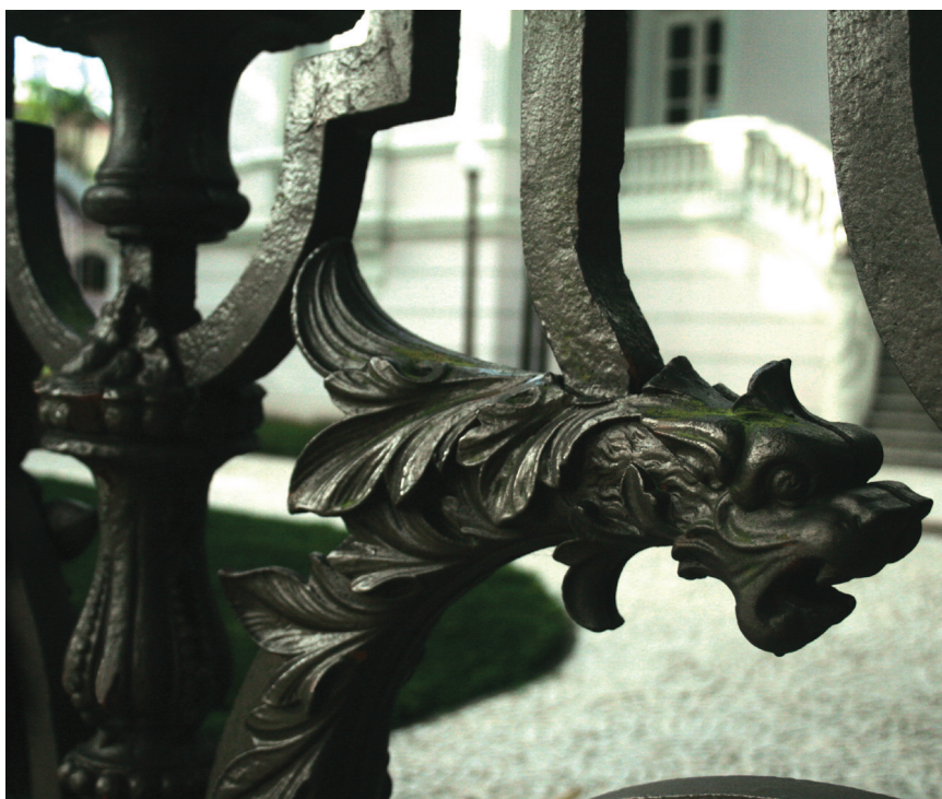
DETALHE dos portões de ferro na entrada da Secretaria de Estado da Cultura
