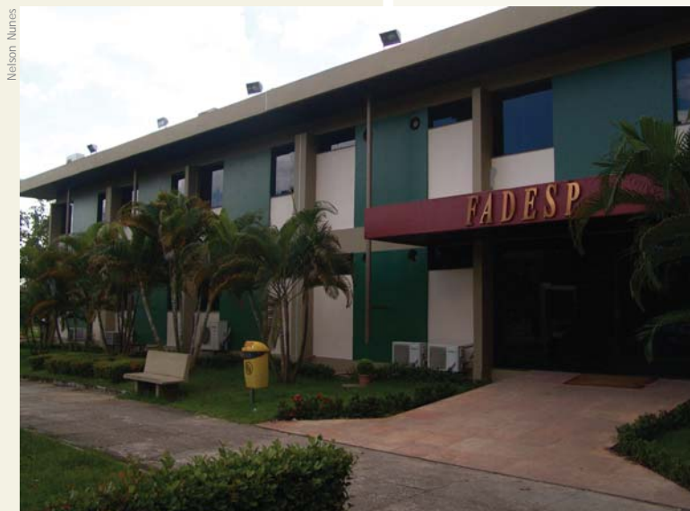
Fachada do prédio da Fadesp, 2007
