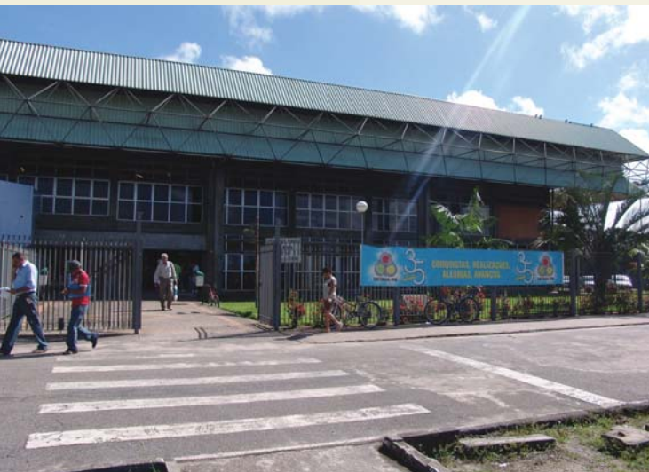
Fachada do Detran em Belém
