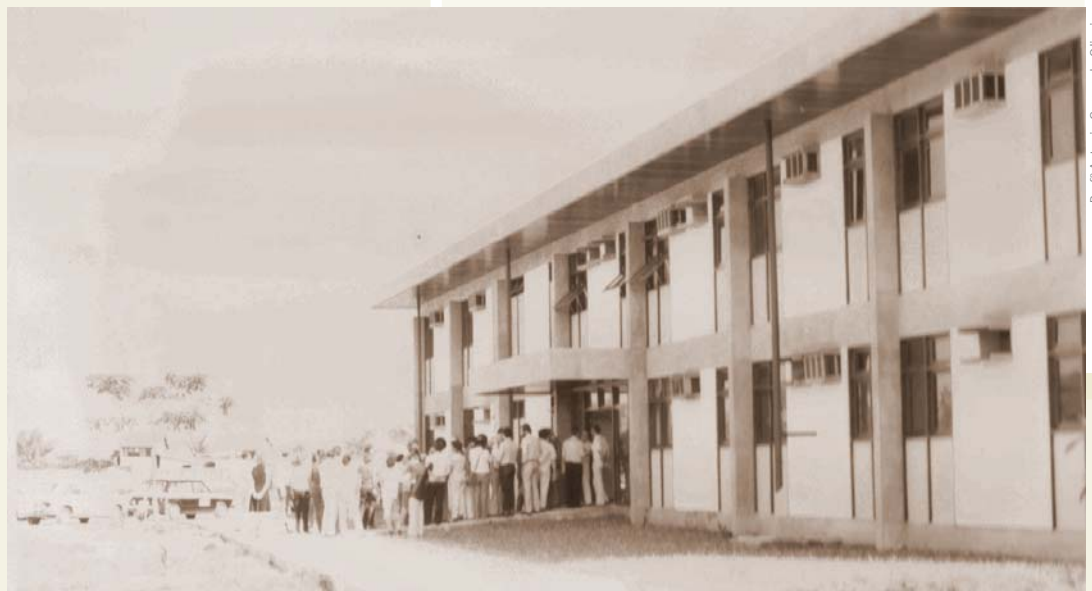
Fachada do prédio da Fadesp, 1983
